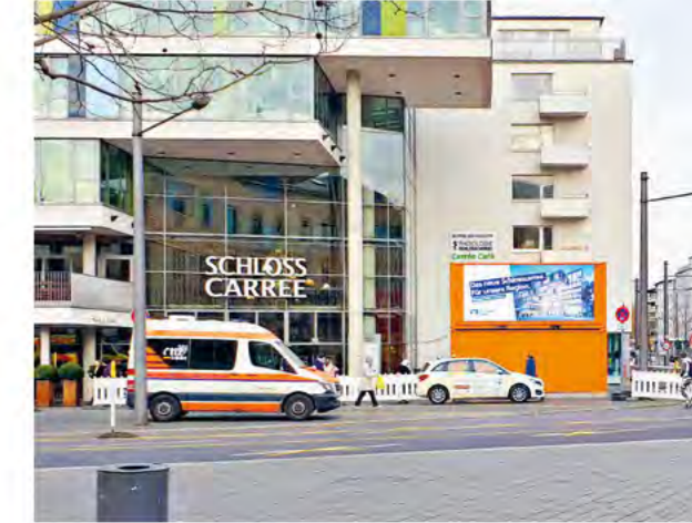
Die äußerlich sichtbaren Umbauarbeiten am Schlosscarree sind in vollem Gange
